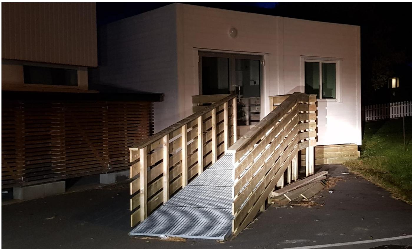
Modulbygget ved Spjelkavik stasjon.
